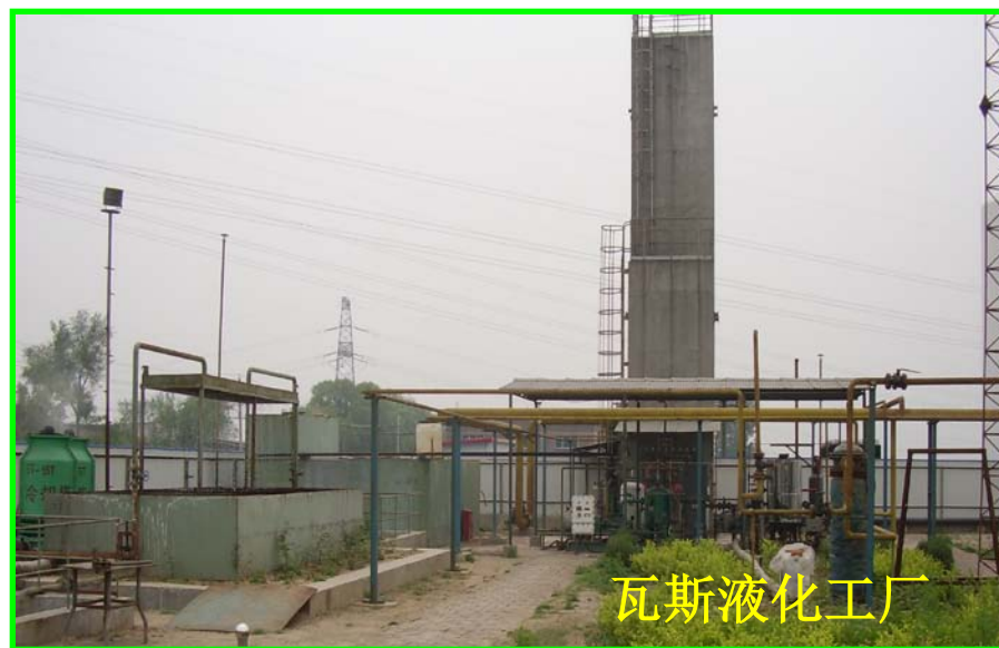
图 建设中的阳泉煤层气液化工厂
