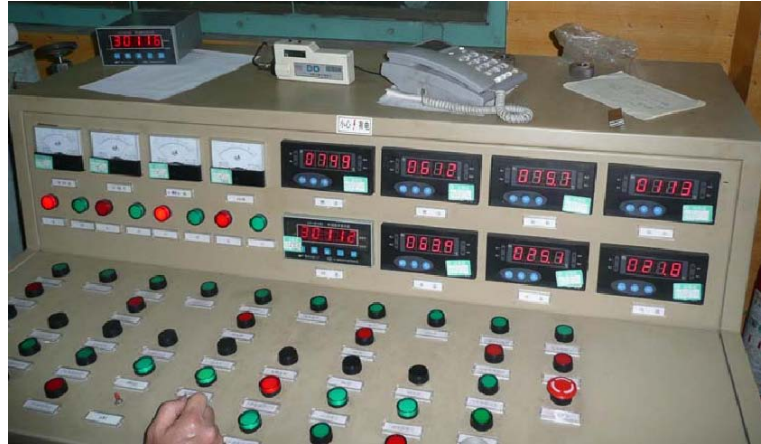
Turbine block test 汽轮机台架 试验
